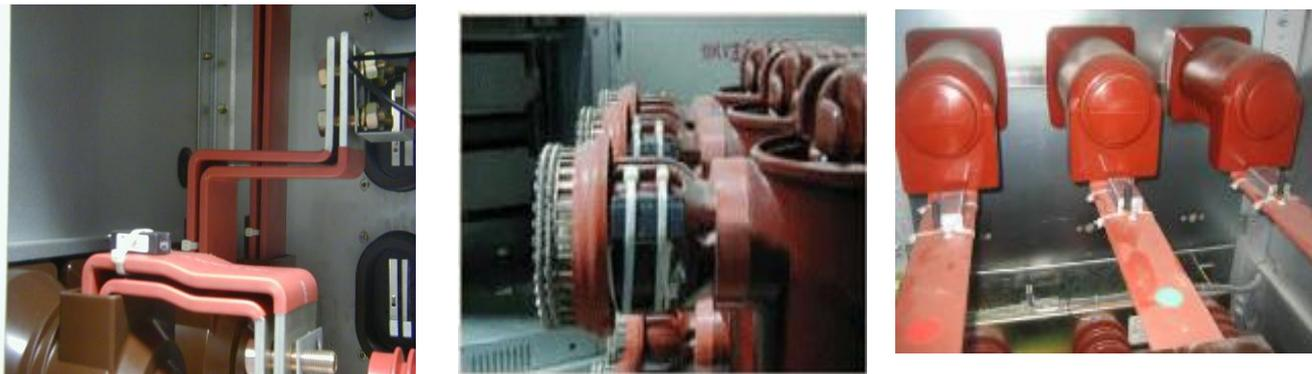
图 4-3 无线温度传感器安装
